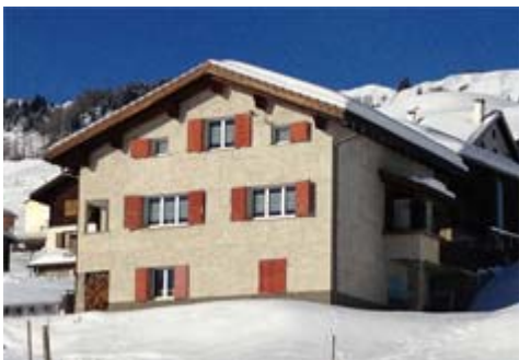
EFH vor der Sanierung
