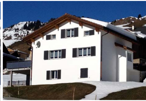
EFH nach der Sanierung
